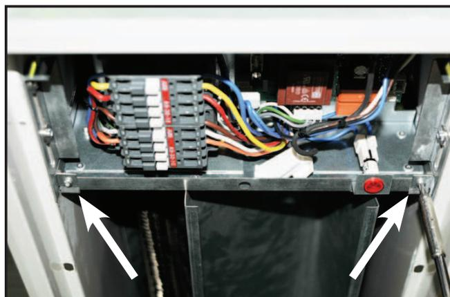
Verrouiller le bloc de ventilation sur les glissières à l'aide de 2 vis.
