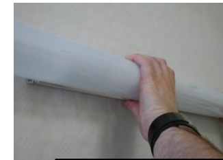
Clipser l'écran et coulisser jusqu'à appui dans l'embout. Remettre l'embout enlevé à la 1ère étape.
