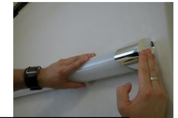
Clipser l'écran et coulisser jusqu'à appui dans l'embout. Remettre l'embout enlevé à la 1ère étape.
