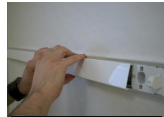
Remettre le cache avant de brancher un tube fluorescent.
