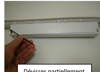
Dévisser partiellement les 2 vis supérieures.
