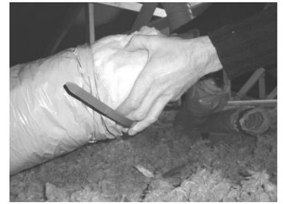
Positionner l'isolant jusqu'à la rainure A
