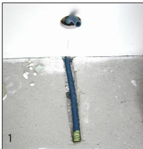
Positionner la boîte de raccordement sur la cloison à l'aide d'une scie cloche, puis mettre en place la gaine recevant la sonde et celle comportant la liaison froide qui devra être coupée dès sa sortie de la cloison.
