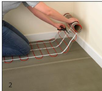
Après avoir vérifié l'état de surface (planéité, aspérité), dérouler la trame chauffante. Recouvrir la surface selon le plan de pose. Découper la trame pour permettre la juxtaposition des lés. Attention à ne pas sectionner ou écraser le câble chauffant.
